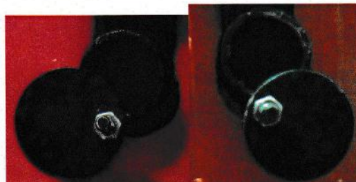
Rys. 3. Widok przepustnic powietrza wtórnego strona lewa i prawa.
